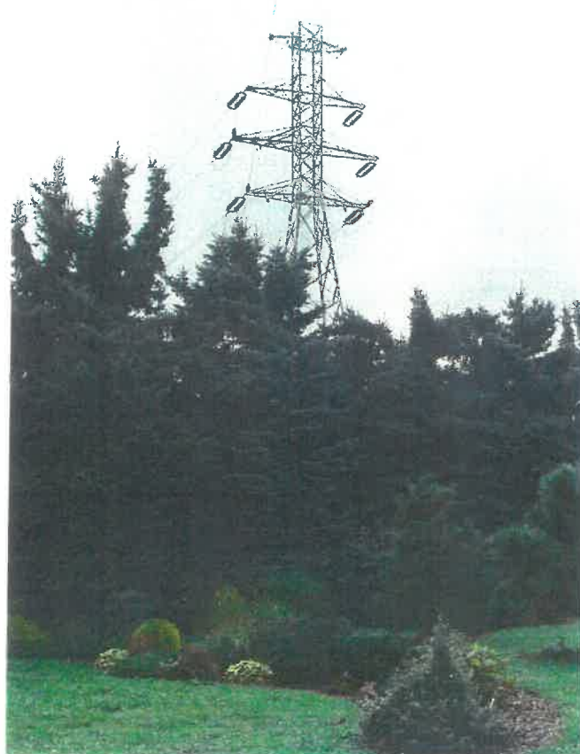
Rys. 2.7. Słup nr 16 linii 110 kV relacji TARNÓW – PONAR, widok od strony działki nr 15/4, obręb 290
