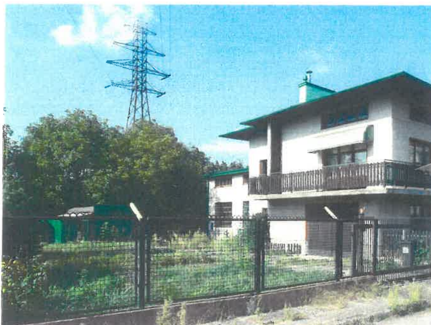
Rys. 2.8. Słup nr 17 linii 110 kV relacji TARNÓW – PONAR, widok od strony działki nr 40, obręb 290
